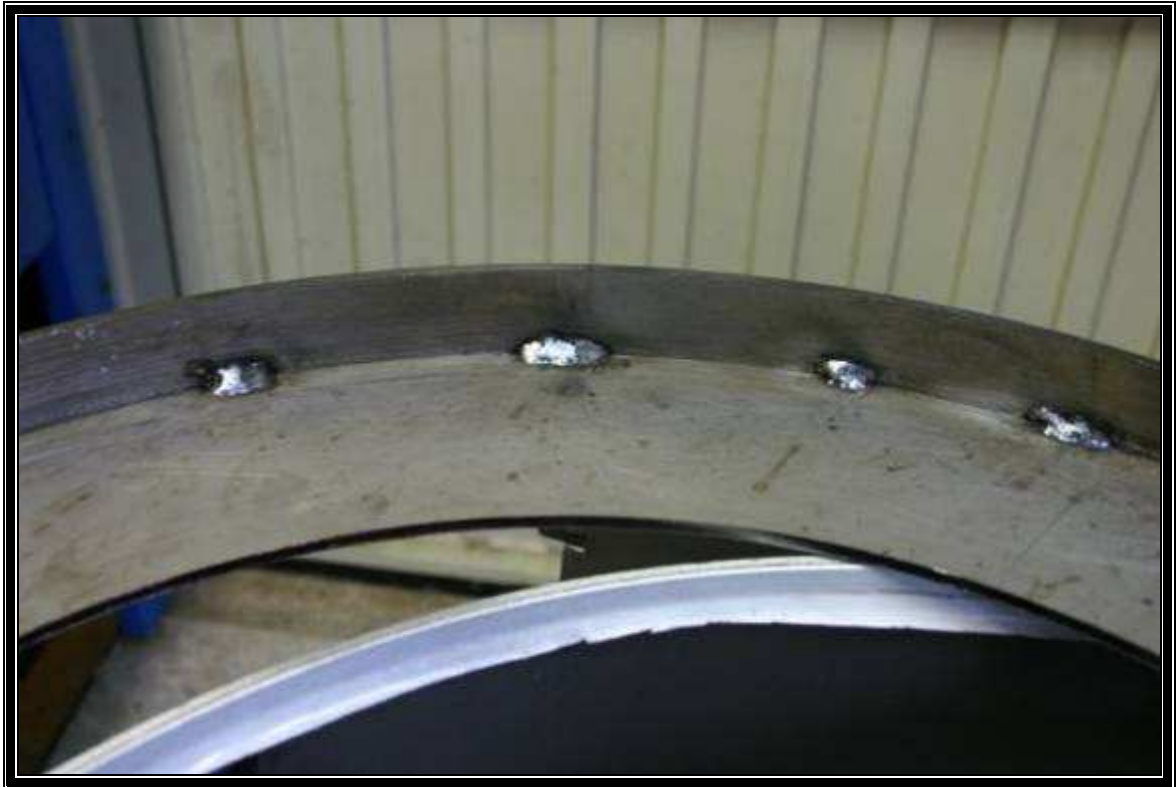
10/1480-Detalle de la soldadura pletina-arandela.
